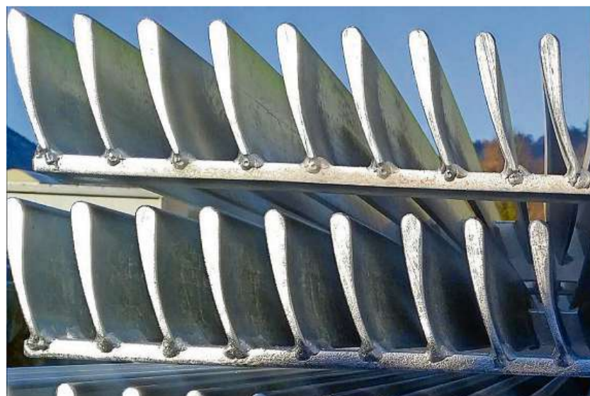
Die Strömung macht: Die Stäbe des prämierten Fischleitrechens haben einen speziellen Querschnitt und werden im Fluss so ausgerichtet, dass sie den Fischen den Weg zum Bypass weisen.
