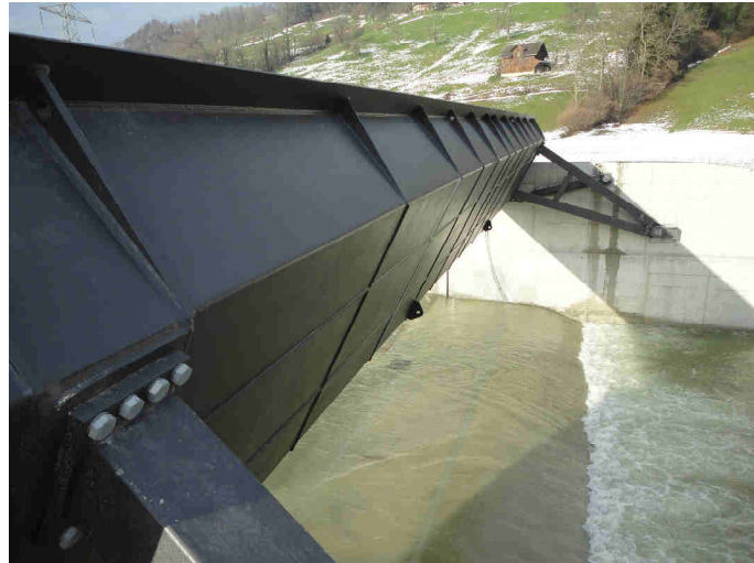
Abbildung 1: Segmentschütze BiL = 21m
